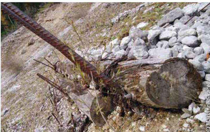
*Diese Pilotenwand mit zwei Querhölzern kann dem Druck nicht mehr lange standhalten.*
