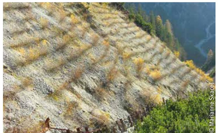
*Flächig eingearbeitete Weidenflechtzäune sind Sofortmaßnahmen zur Sicherung bzw. Rückhalt von Oberböden.*
