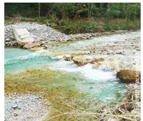
Eine neue Betongrundschnelle nach der Umsetzung – kein Hindernis mehr für Fische bei der Wanderung
