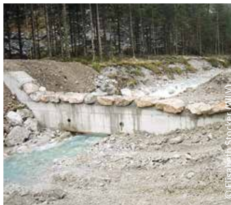
Eine Betongrundschnelle während der Bauphase. Im unteren Bereich sieht man auch die Löcher im Beton, welche kleinen Tieren in der Gewässersohle unterhalb des Bachbettes eine Wanderung ermöglichen sollen.
