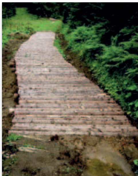
Prügelweg nach der Sanierung
