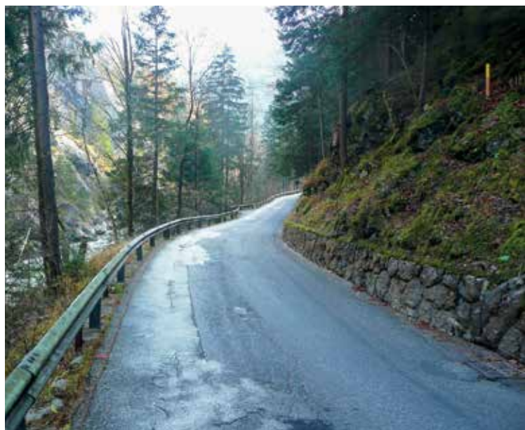
Naturnabe Gestaltung der Hangstützmaßnahmen durch eine Strukturbetonschalung und einer Natursteinschichtung.
