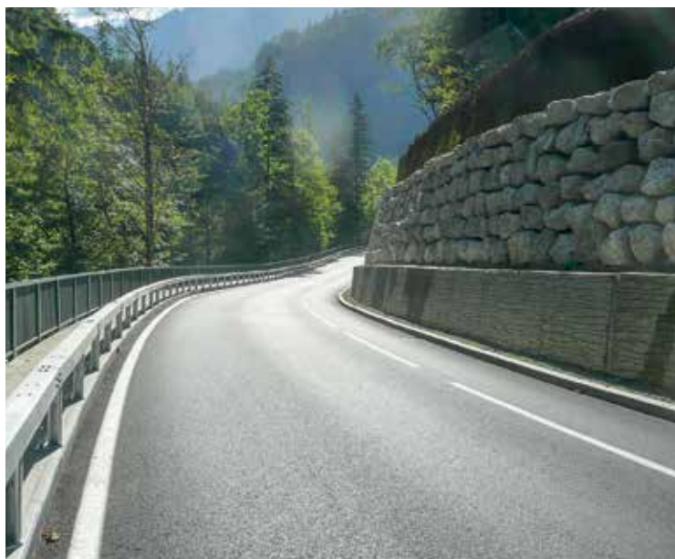
Naturnabe Gestaltung der Hangstützmaßnahmen durch eine Strukturbetonschalung und einer Natursteinschichtung.
