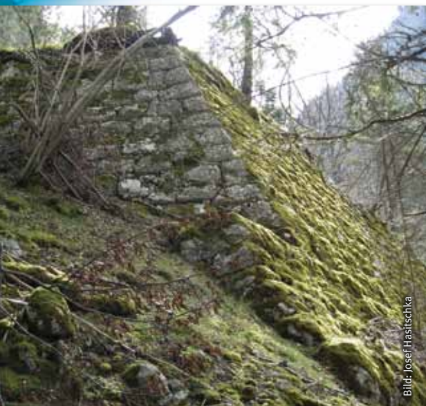
8 m hohe Trockensteinschlichtung
