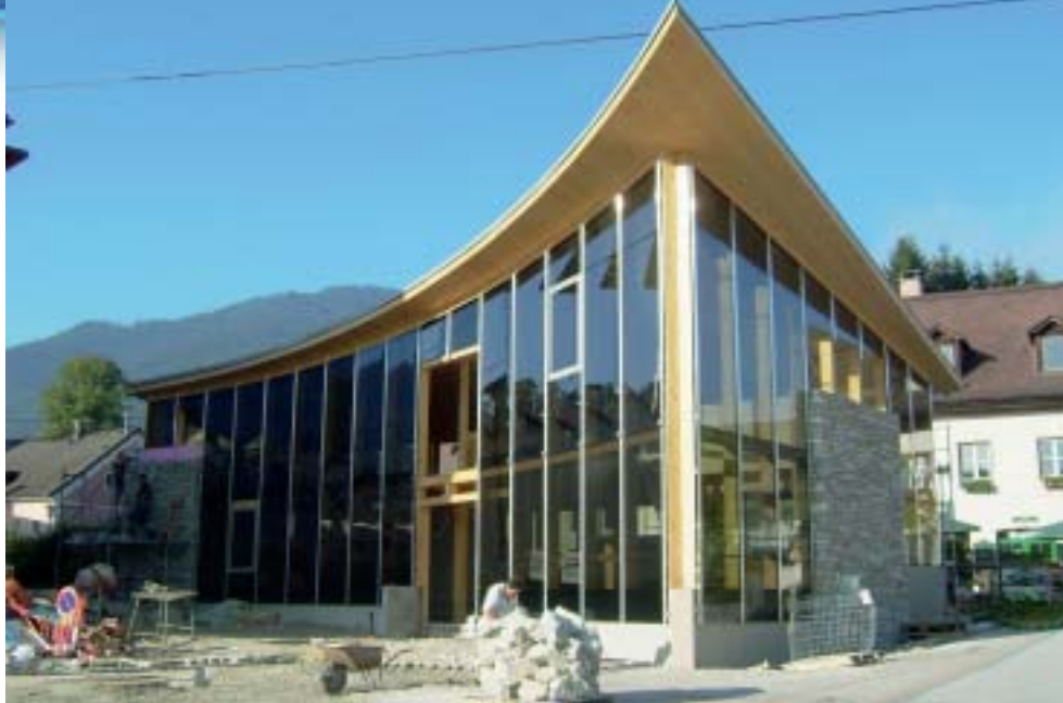
Der Rohbau des Infobüros im September
