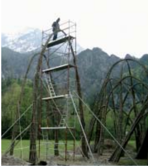
Baustelle in luftiger Höhe
