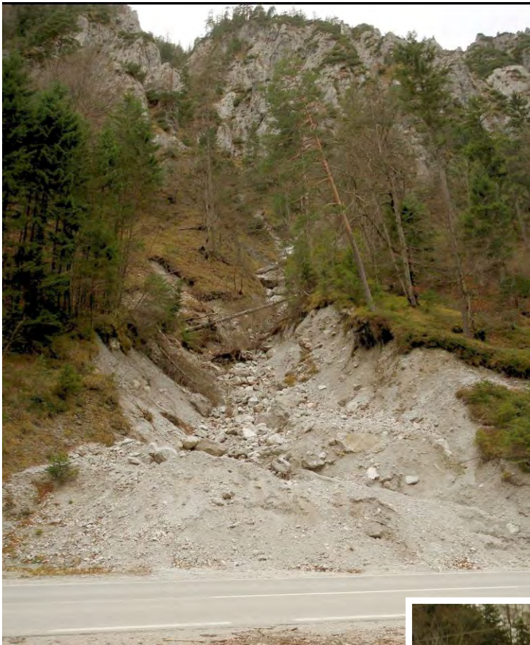
Bild 42: Fehringerkreuzgraben und Johnsbacher Landesstraße L 743. - Foto: Haseke 23.11.2010
