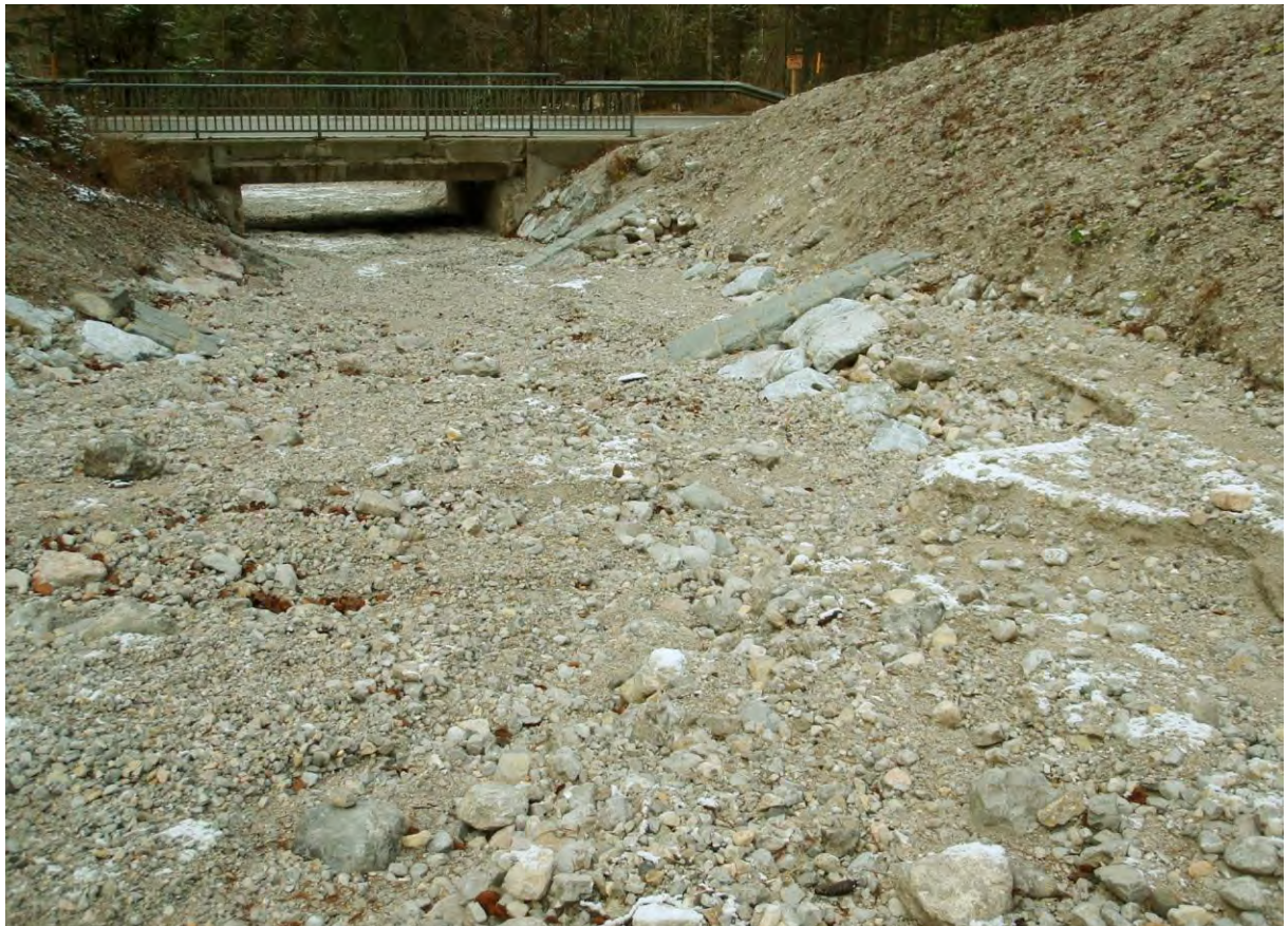
Bild 62: Schneiderwartgraben – Brücke der B146 von oben. Foto: Haseke 25.11.2010
