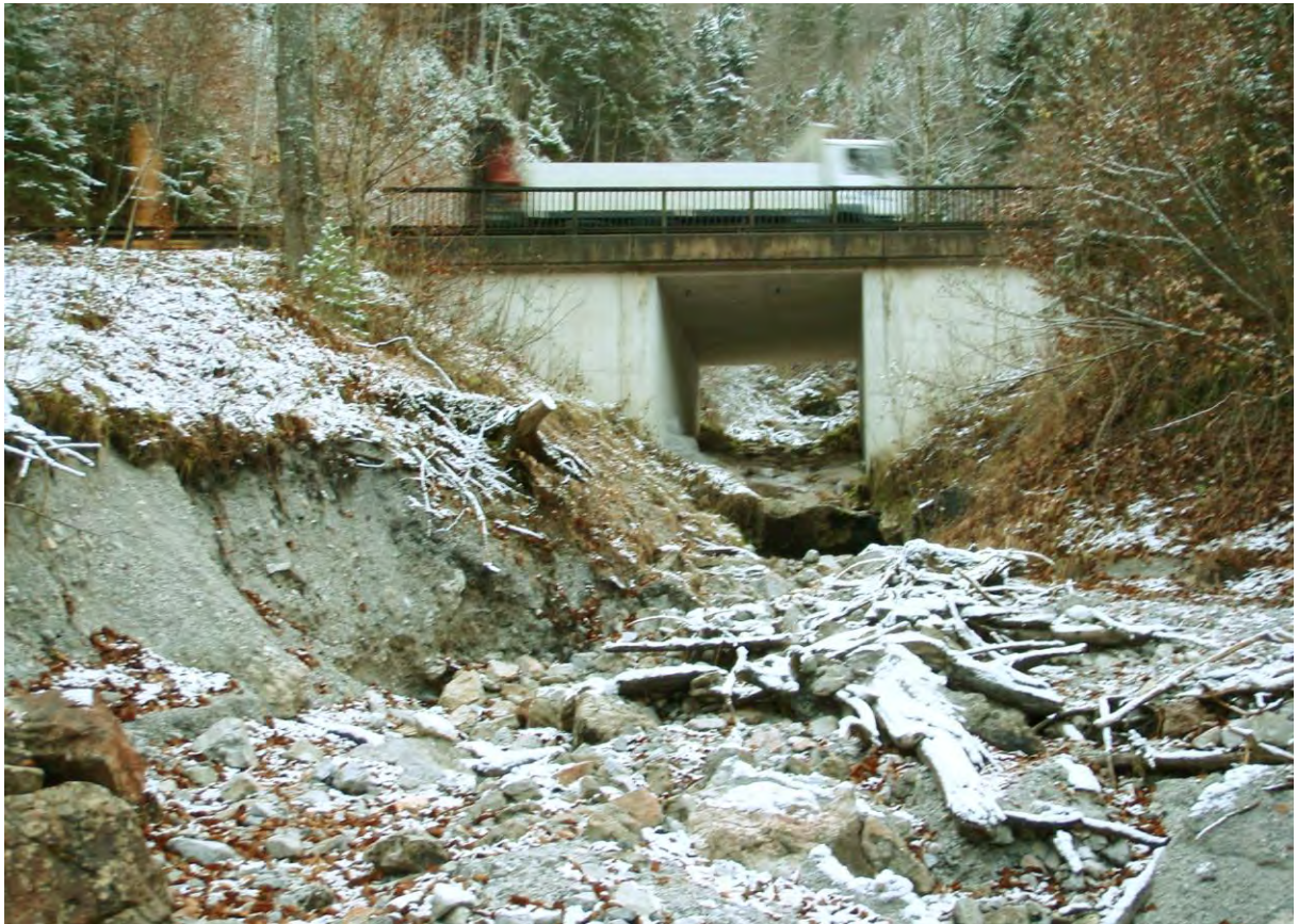
Bild 3: Haspelgraben Brücke B 146 von unten. Foto: Haseke 25.11.2010
