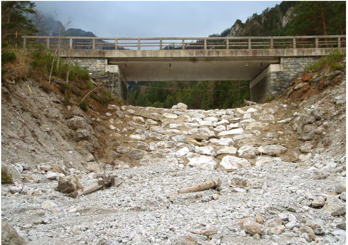
Bild 28: Langgries Brücke L 743 von unten. Die Steilstufe nach dem Durchlass kann die Anhäufung des Geschiebes an der künstlichen Egstelle nicht verhindern. - Foto: Haseke 23.11.2010
