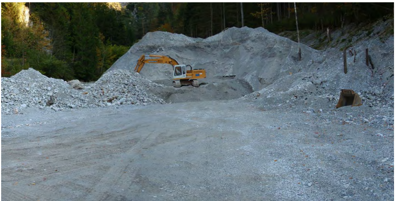
Bild 15: Humlechnergraben, Abbau der Sprengschutthalde nahe Mündung am Schluchtausgang. - Foto: Haseke 4.10.2010
