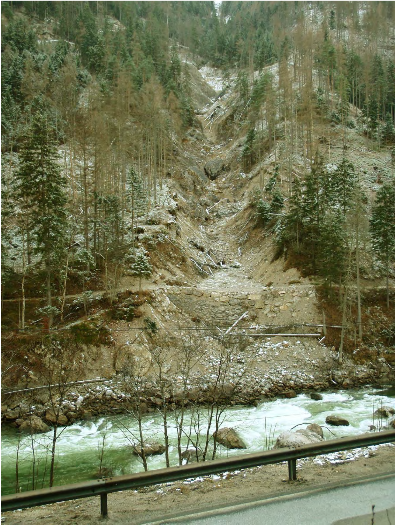
Bild 71: Planspitzgraben – Totale mit gemauerter Forststraßenfurt (Ennsbodenweg) und mit dem nach einem Murenabgang 2006 entstandenen Ennskatarakt. - Foto: Haseke 25.11.2010
