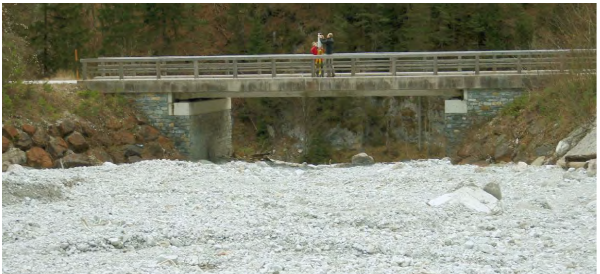
Bild 28: Langgries Brücke L 743 von unten. Die Steilstufe nach dem Durchlass kann die Anhäufung des Geschiebes an der künstlichen Egstelle nicht verhindern. - Foto: Haseke 23.11.2010
