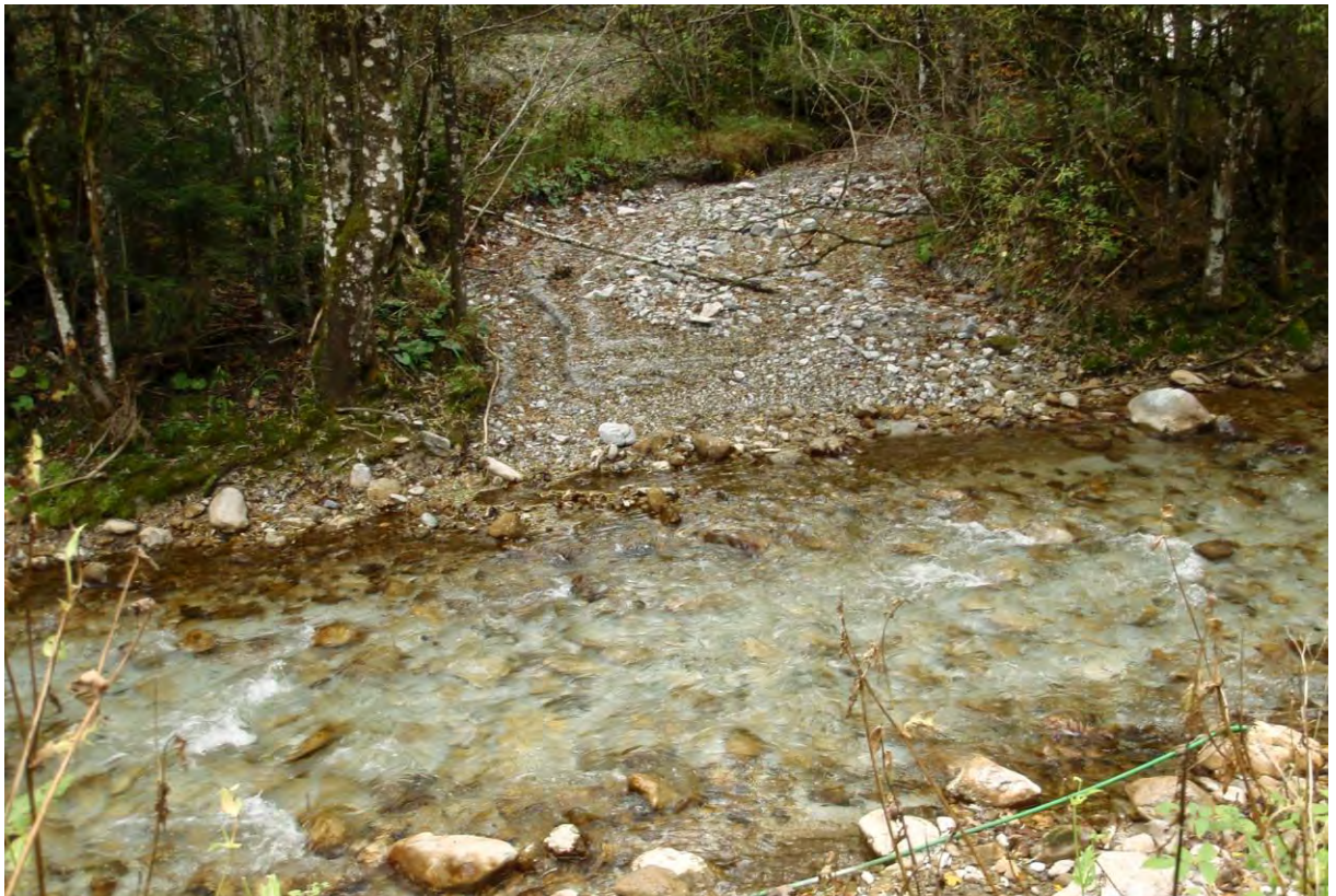
Bild 14: Humlechnergraben Mündung, Blick vom Ufer unweit Gasthof Bachbrücke. Der Johnsbach ist hier aus Sicherheitsgründen noch "originalverbaut", hier können auch künftig noch Bachbetträumungen notwendig werden. - Foto: Haseke 28.11.2010
