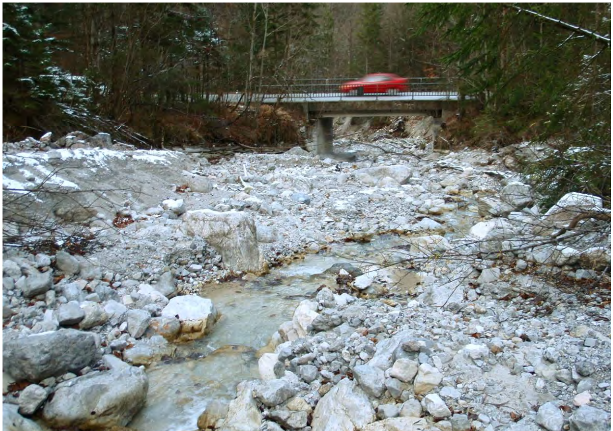
Bild 2: Gofergraben Brücke B 146 von oben. Foto: Haseke 25.11.2010
