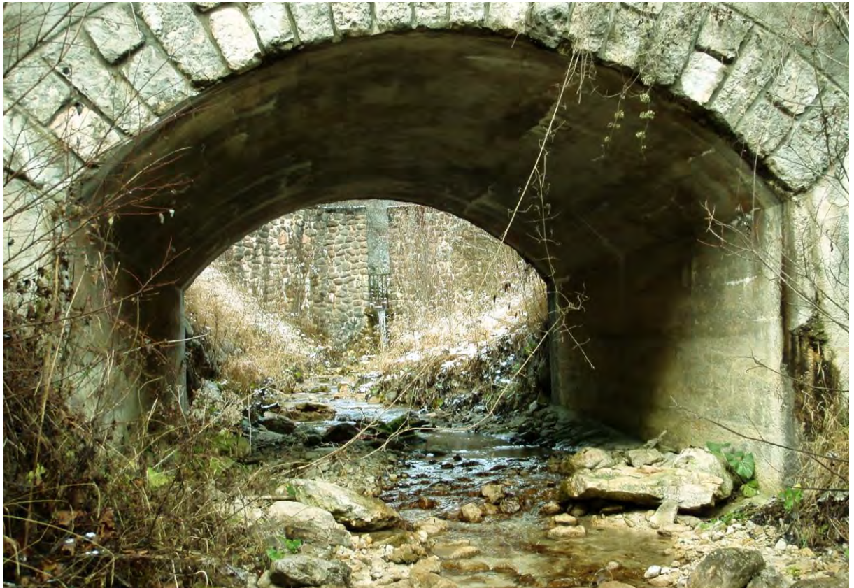
Bild 80: Klausgrabenmündung – Straßendurchlass B 146 und Geschiebesperre im Hintergrund. Das Sammelgerinne des Gstatterbodener Kessels führt hier kein Geschiebe. - Foto: Haseke 25.11.2010
