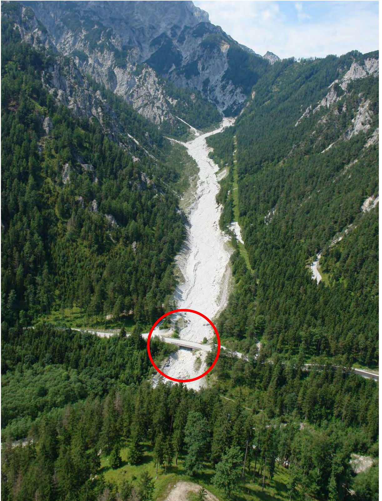
Bild 27: Langgries mit der Brücke der Landesstraße L 743 von Osten (Flugbild). Trotz der relativ großzügigen Bauweise bildet der Durchlass ein Nadelöhr. - Foto: Kreiner 31.7.2006
