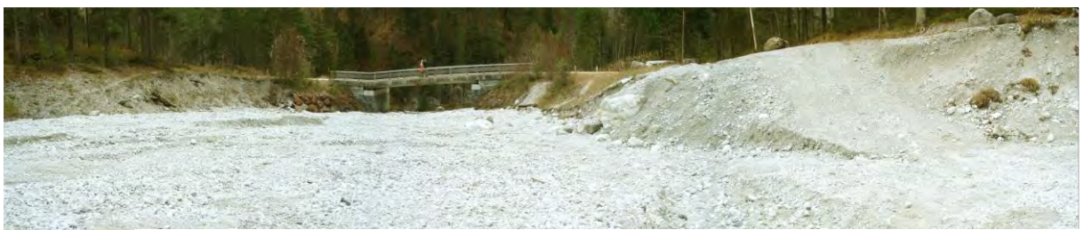
Bild 29: Langgriesbrücke L 743 von oben, Die Straße quert den Schuttstrom am Niveau der alten Oberfläche des Schuttkörpers (vor dem Abbau?) - Fotos: Haseke 23.11.2010
