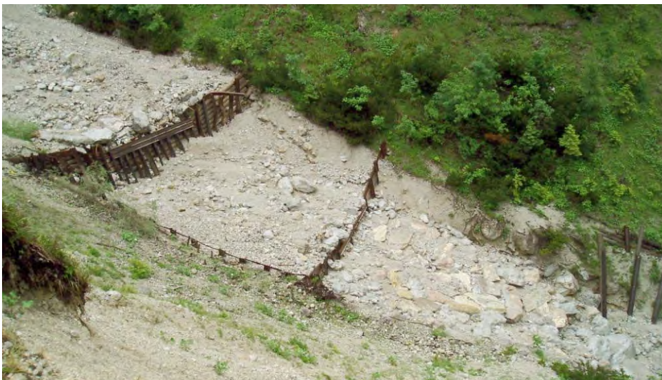
Bild 57 und 58: Kühgraben – Hangverbauungen (oben) und Geschiebeebremsen (unten) der WLV im oberen Grabenabschnitt. – Fotos: Haseke 18.6.2008
