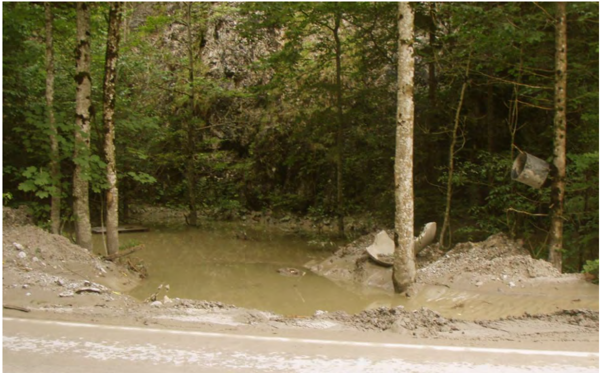
Bild 46 und 47: Abwärts Fehringerkreuzgraben. Der Stau entlang der Johnsbacher Landesstraße L 743 führt bei Hochwasser zur Verschüttung und Verschlammung von Boden und Vegetation, bis hin zum Absterben der Bäume. – Foto: Haseke 16.8.2008
