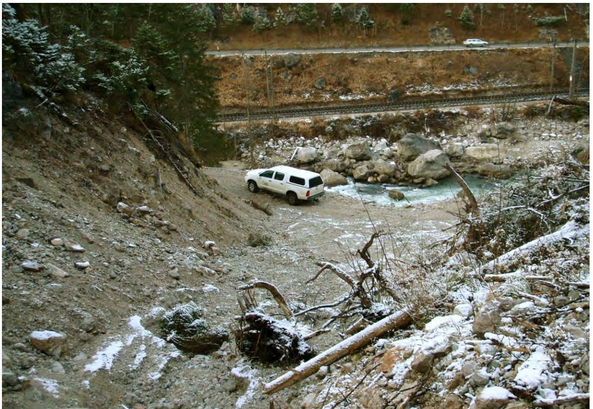
Bild 73: Planspitzgraben – Forststraßenfurt und die nach dem Murenabgang in den Gefahrenbereich gerückte Bahnstrecke am anderen Ennsufer. - Foto: Haseke 1.8.2007
