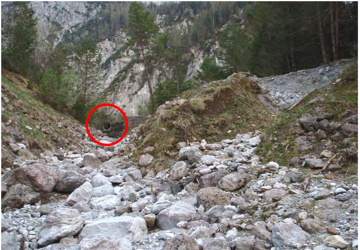
Bild 18: Gsenggrabenmündung mit der blockierenden Furt der Betriebsstraße im April 2010. Der geschiefbeführende Graben wurde seitlich ausgelenkt! - Foto: Haseke 27.4.2010
