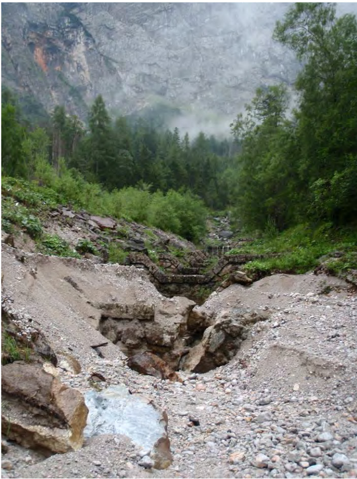
Bild 84 (oben): Wasserfallgraben. Desolate Verbauung und kaputte Querung des Ennsbodenweges im Talbereich. - Foto: Haseke 30.07.2012
