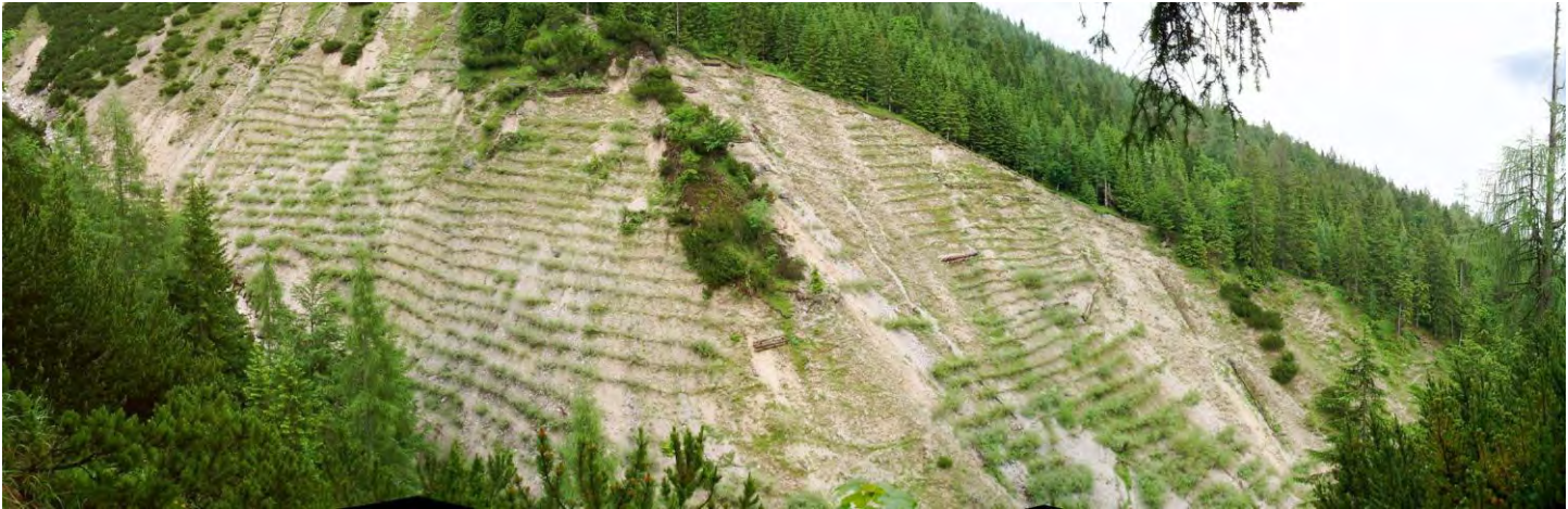
Bild 57 und 58: Kühgraben – Hangverbauungen (oben) und Geschiebeebremsen (unten) der WLV im oberen Grabenabschnitt. – Fotos: Haseke 18.6.2008
