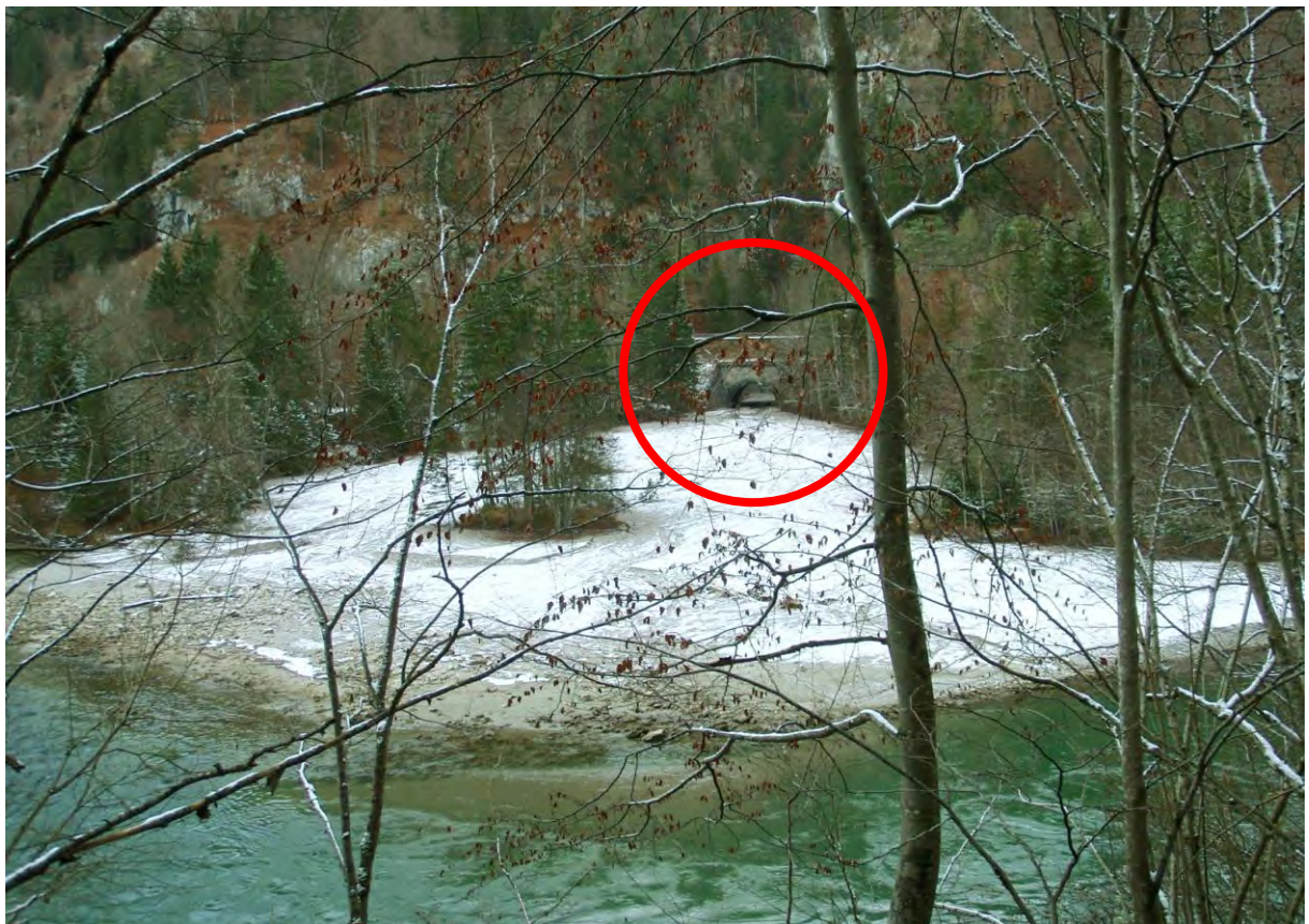
Bild 6: Bruckgraben Mündungskegel und Durchlass der Bahnstrecke. Foto: Haseke 25.11.2010
