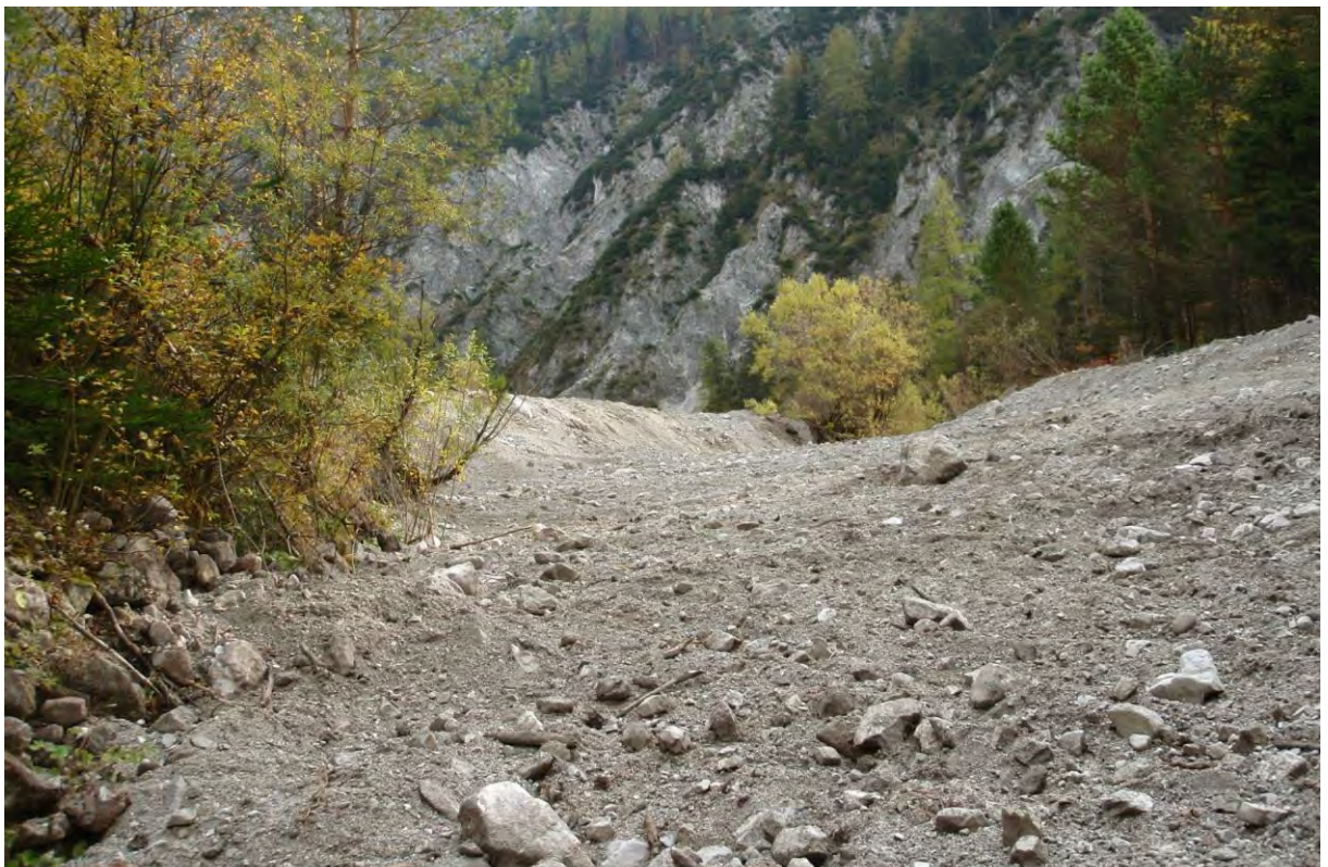
Bild 19: Gsenggrabenmündung nach Rückbau und Aufweitung - Foto: Haseke 23.10.2010
