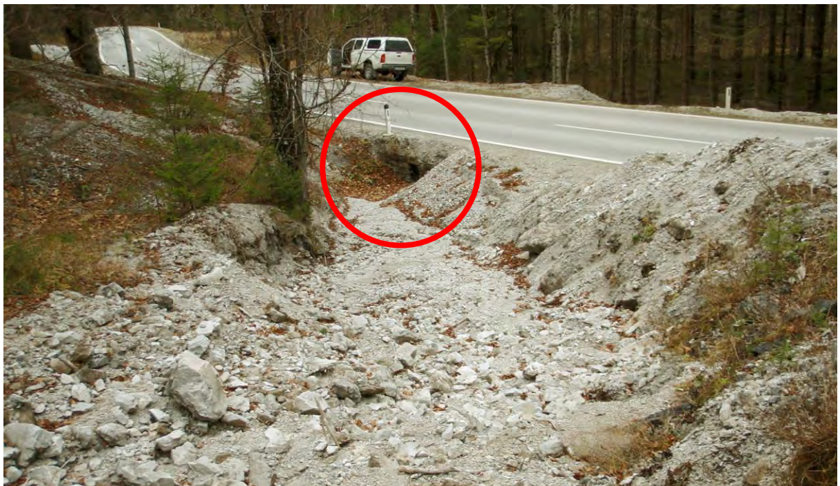
Bild 45: Unbenannte Runse nördlich Fehringerkreuzgraben, ebenfalls unzureichender Durchlass durch die L 743. – Foto: Haseke 23.11.2010
