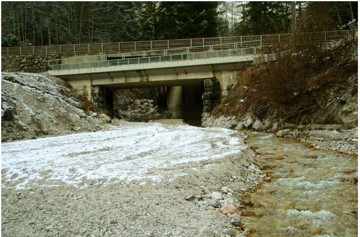
Bild 74: Weissenbachl – Mündung mit niedrig angesetzter Bahnbrücke ÖBB (im Vordergrund) und Straßenbrücke B 146, die wesentlich mehr lichte Weite aufweist. - Foto: Haseke 25.11.2010
