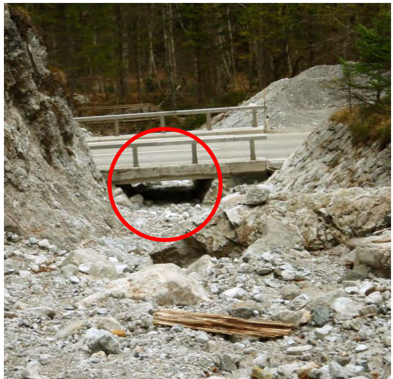
Bild 39: Buckletschneidergraben Brücke L 743. – Foto: Haseke 23.11.2010
