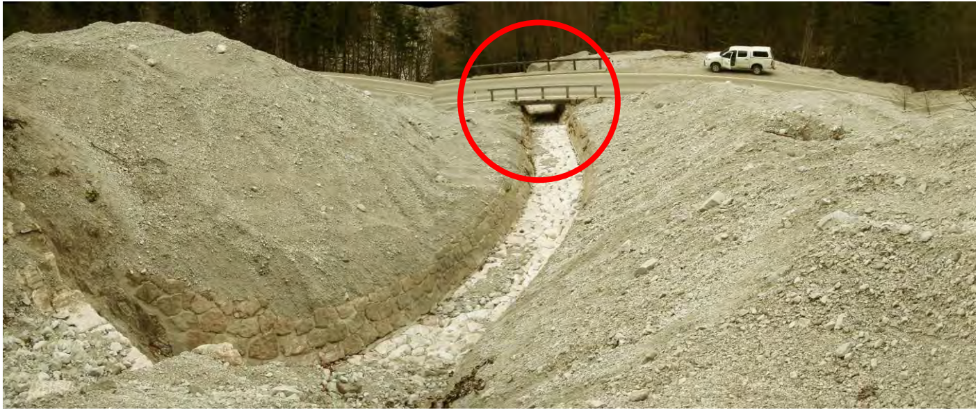
Bild 35: Mitterriegelgraben Brücke L 743 von oben. - Foto: Haseke 23.11.2010
