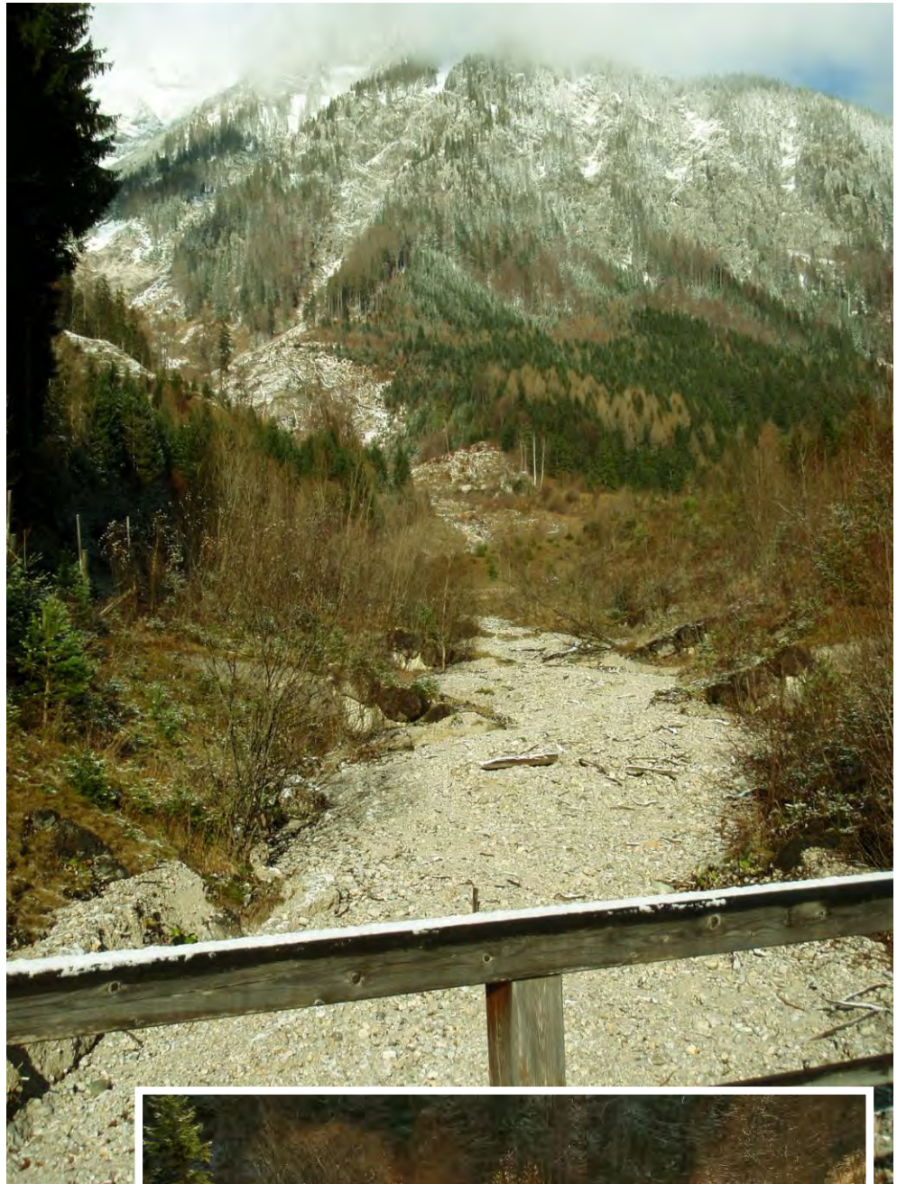
Bild 60: Rotgraben – Brücke Forststraße Rauchbodenweg. Foto: Haseke 25.11.2010
